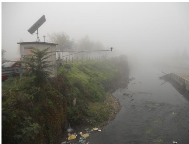
Figura 5 – tratto di sponda oggetto di sopralzo e vano idrometro da spostare
